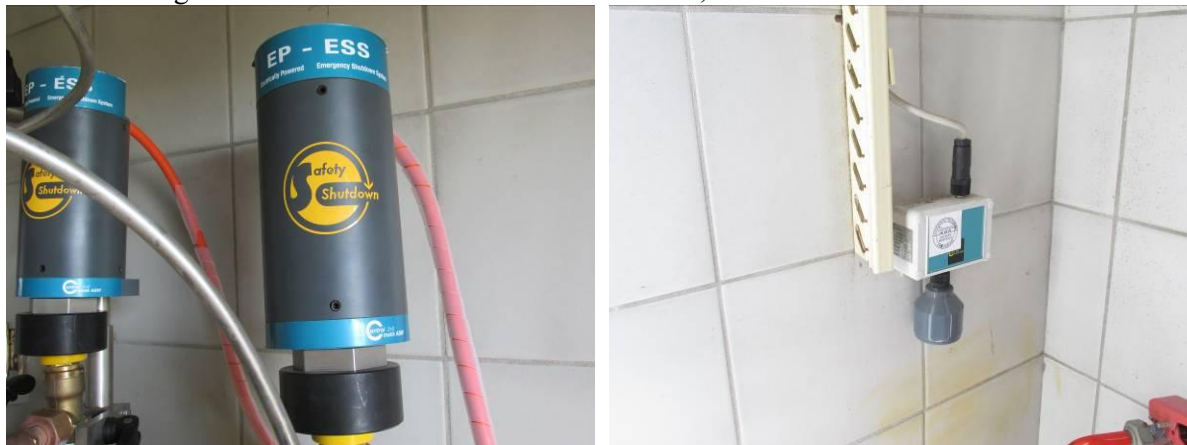
Slike 3 i 4: Sigurnosni automatski zatvarači boce s klorom; Detektor kloro
